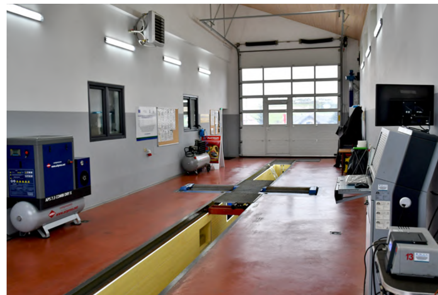
Cząszyn - wnętrze stacji
